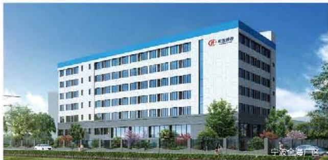
宁波金海厂区
